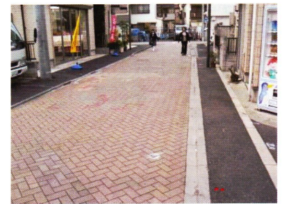
まもなく整備が完了する幅員6mの主要生活道路（東四つ木地区）
